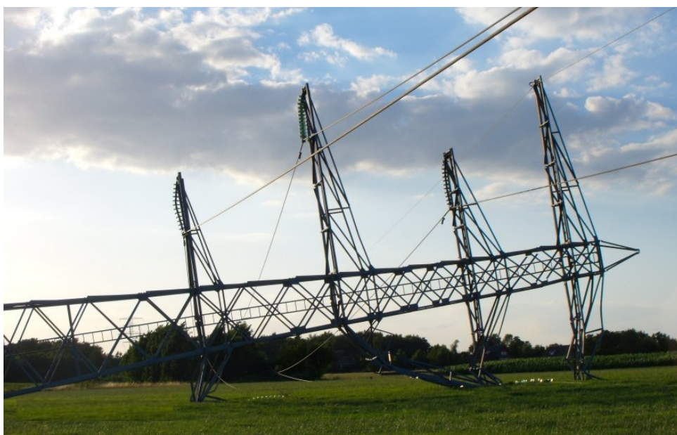
Figuur 50. Omgevallen hoogspanningsmast (Bron:Jacob Kuiper/KNMI)
