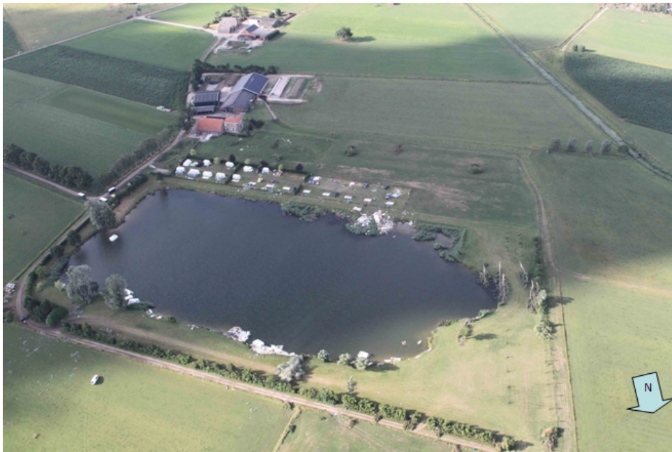
Figuur 6. Overzicht van de ravage op de camping (Bron: KLPD)
