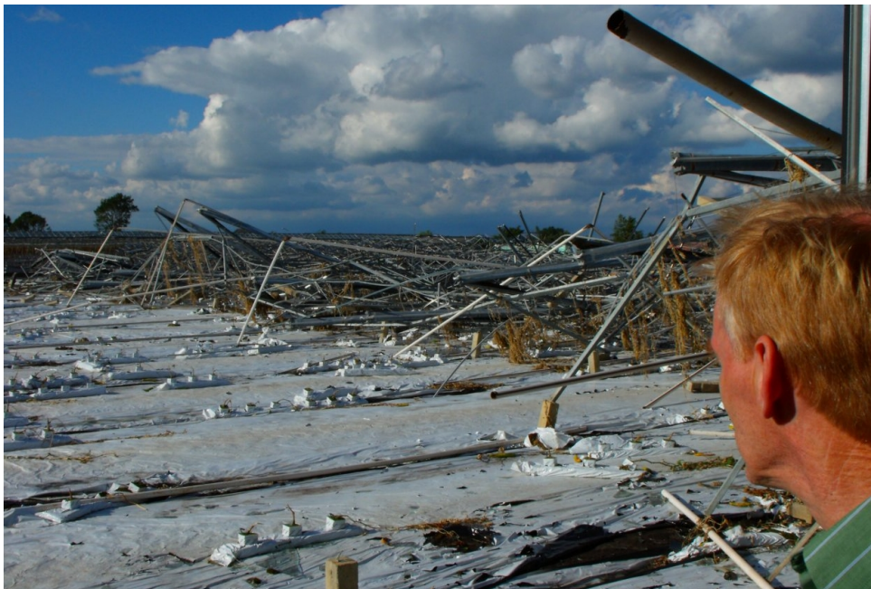
Figuur 8. Totaal vernield en verschoven kassencomplex in Neerkant (Bron:Jacob Kuiper/KNMI)
