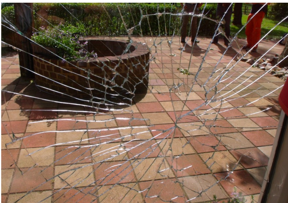
Figuur 5. Binnenglas van dubbele beglazing is gesprongen (Bron:Jacob Kuiper/KNMI)
